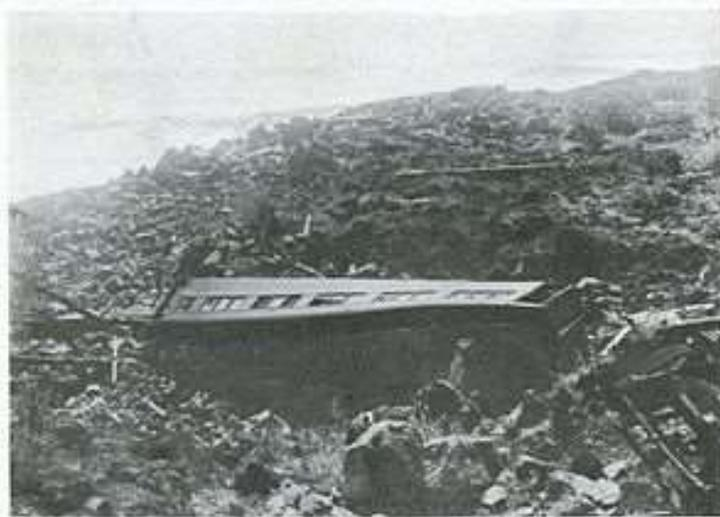
根府川駅列車転覆事故の現場。写真は、1923年9月1日に発生した大正関東地震による根府川駅付近の地滑りによる土石流に遭遇し、根府川駅の駅舎やホームなどの構造物もろとも海側に脱線転覆して、最後部の客車2両を残して全てが海中に没してしまった。
